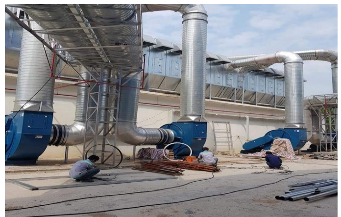
Hệ thống hút bụi gỗ nhà máy gỗ Quảng Trị
