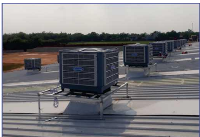
MÁY LẮP TRÊN MÁI
