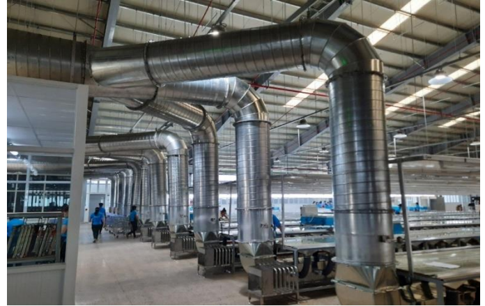
Hệ thống hút bụi xưởng may Viet Pan-Pacific - Thanh Hóa
